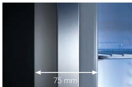
Spessore consigliato della struttura della cella: 75 millimetri.
